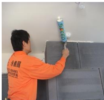
伸縮縫以PU發泡填塞
